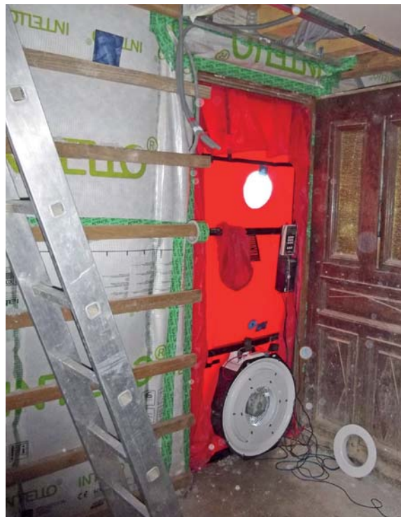
Réalisation d'un test d'étanchéité à l'air intermédiaire, en cours de chantier.
