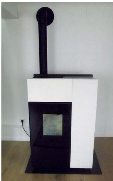
Installation d'un poêle à bois à circuit de combustion étanche.
